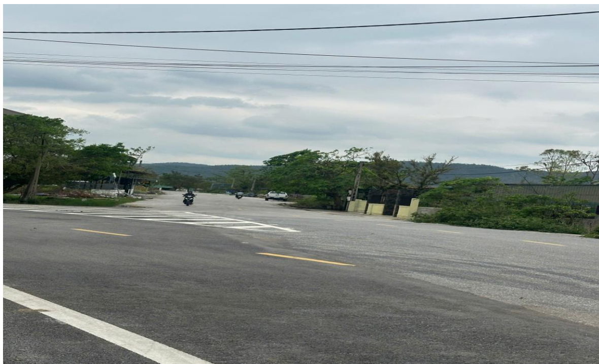
Hiện trạng cuối tuyến bám theo đường hiện trạng
