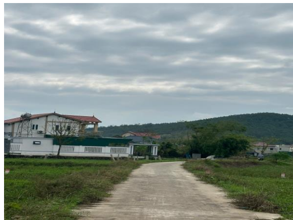
Hiện trạng tuyến qua khu vực dân cư
